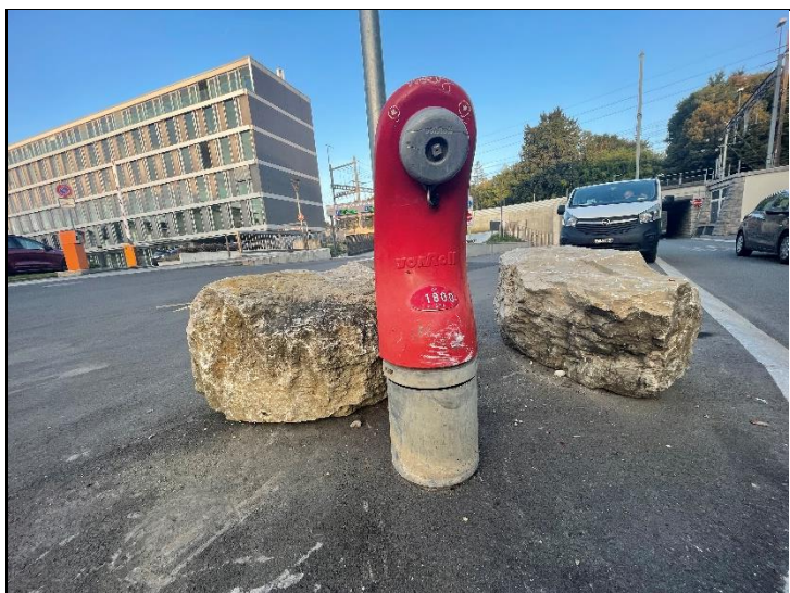
Protection enrochement
