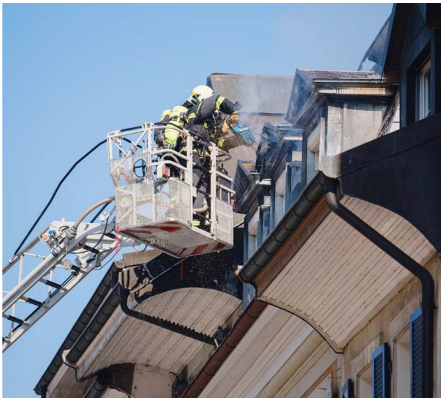
Les pompiers ont dû s'équiper d'une tronçonneuse pour créer des ouvertures afin d'atteindre les flammes.
